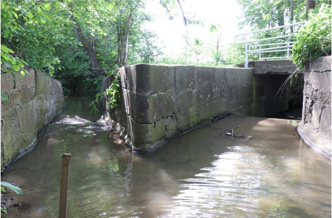
Abb. 46: Wasserweiche „Sulzheimer Eich“. Der nach rechts weiterführende Unkenbach ist mit einer max. Breite von 3,00 m (im Bereich der Einmündung) breiter als der linke, gerade aus verlaufende Seehausbach, der nur max. 1,80 m in der Breite misst.
