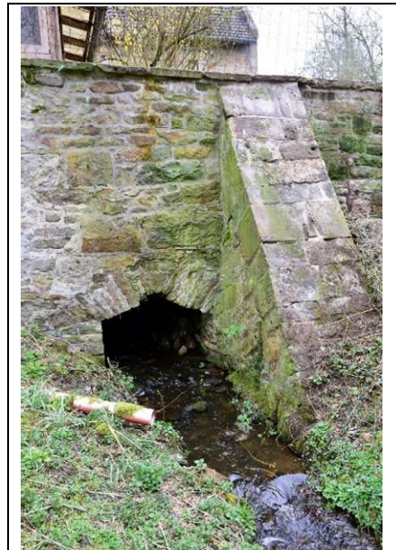
Am Siechenhaus verlässt der Hauptkanal das Kloster.
