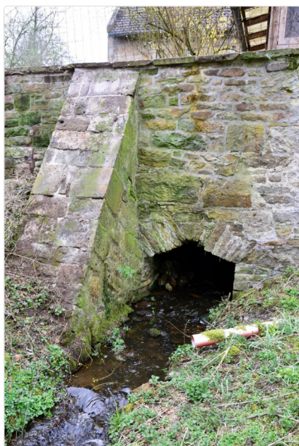
Austritt der Kanalisation an der östlichen Klostermauer
